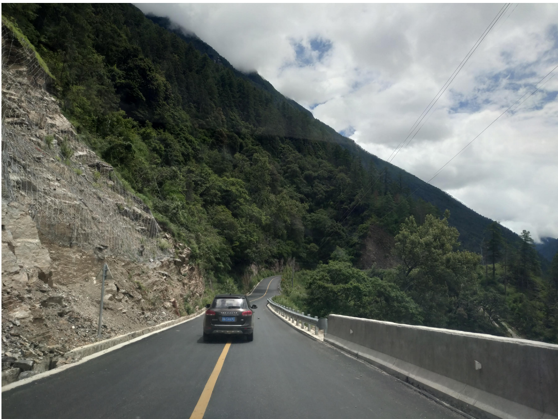
路基工程边沟
