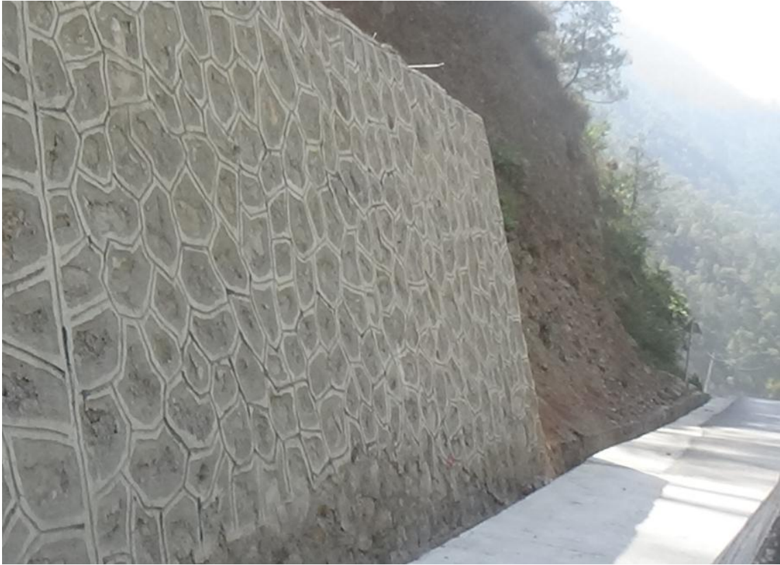
路基工程新修挡墙
