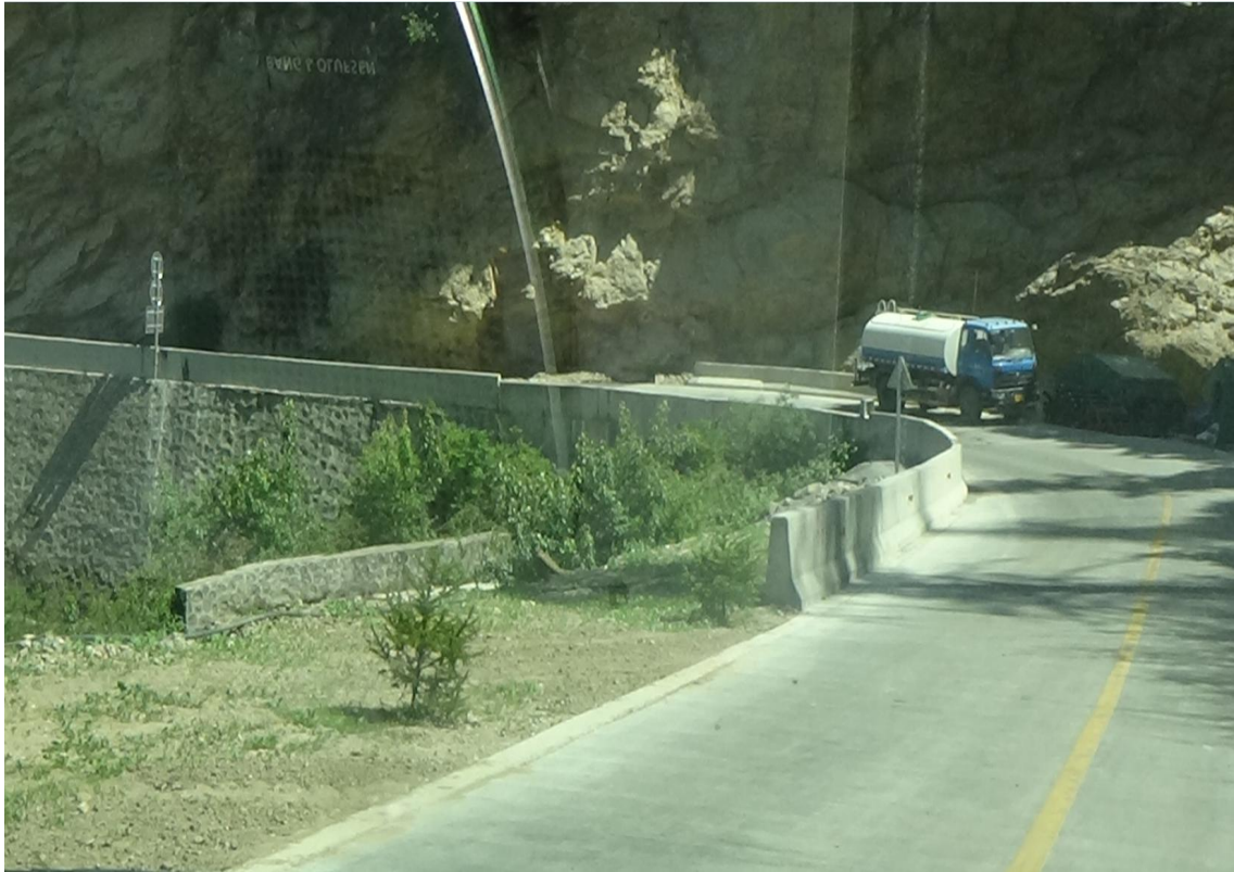
施工期间洒水车洒水
