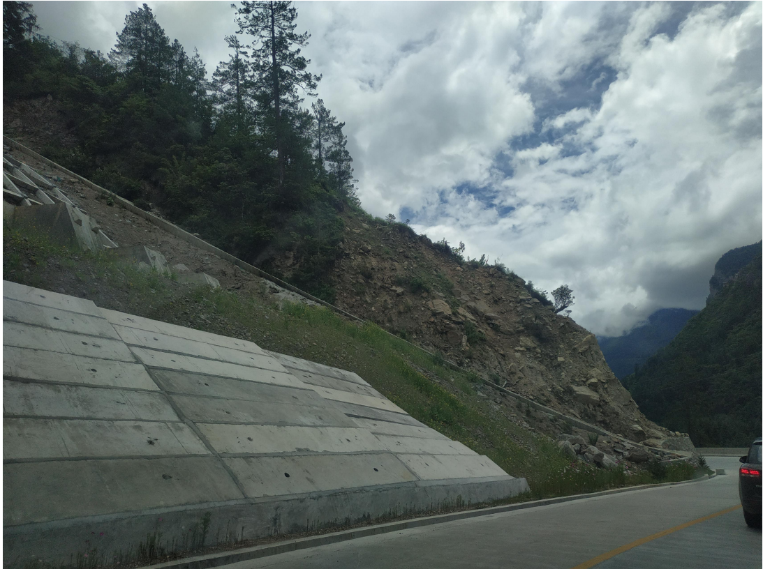
滑坡体周边上边坡绿化
